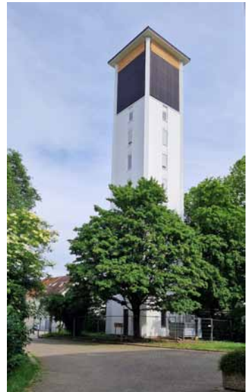
Kirchturm nach der Sanierung im Mai 2026
