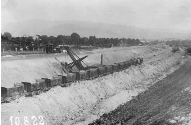
Die Baustellenbahn muss riesige Mengen Aushub wegfahren. Im Hintergrund die OEG-Güterbahn-Brücke („Schwarze Brücke“) (10.8.1922)
