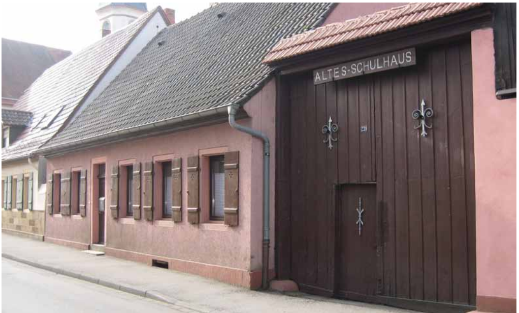
War das unter Denkmalschutz stehende Wackerhaus wirklich das „Alte Schulhaus?“
